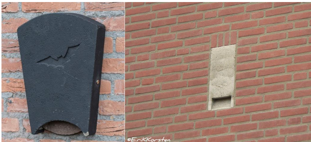
Foto links: opbouw vleermuiskast. Deze kast wordt aan de buitenzijde van de gevel geplaatst. Foto rechts: inbouwkast voor een vleermuis.
