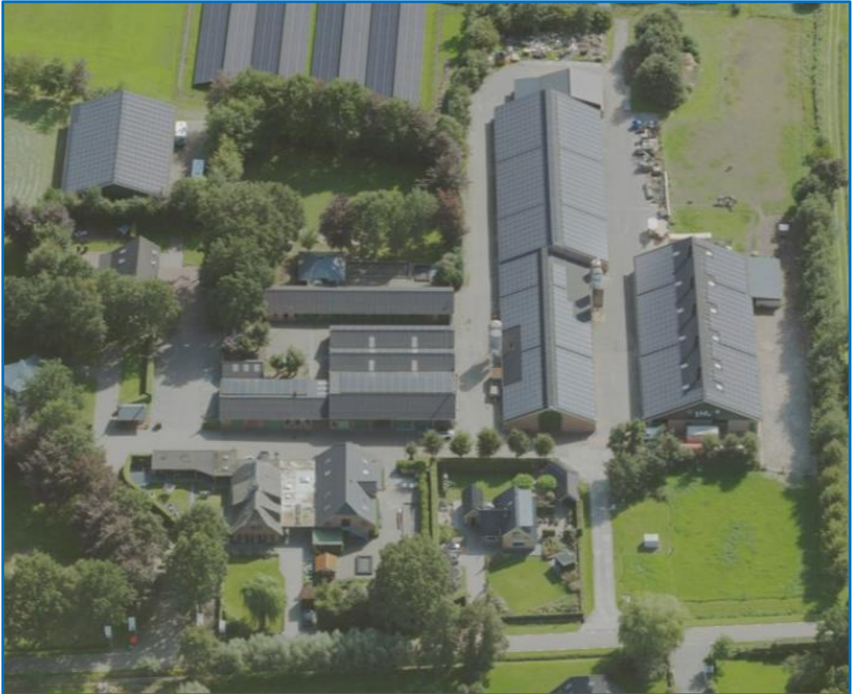
Afbeelding, bouwlocatie Nijkerkerweg 65 (Bron: Street Smart) ([03 september 2023])
