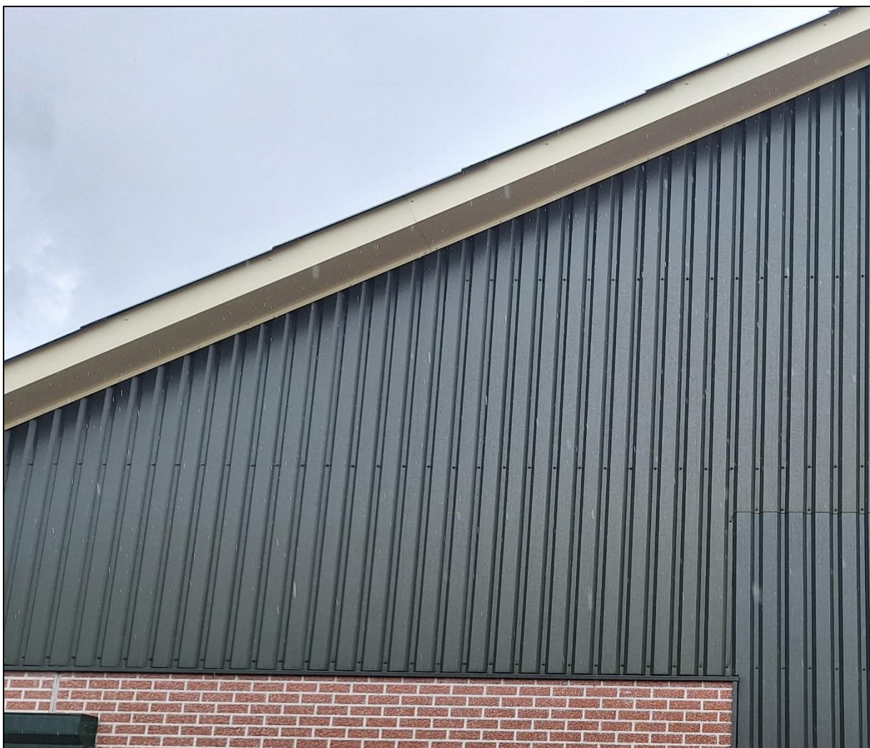
Deel van de kopgevel van een van de stallen. De damwandbeplating sluit nauw aan op delen van het metselwerk en de dak overstek.
