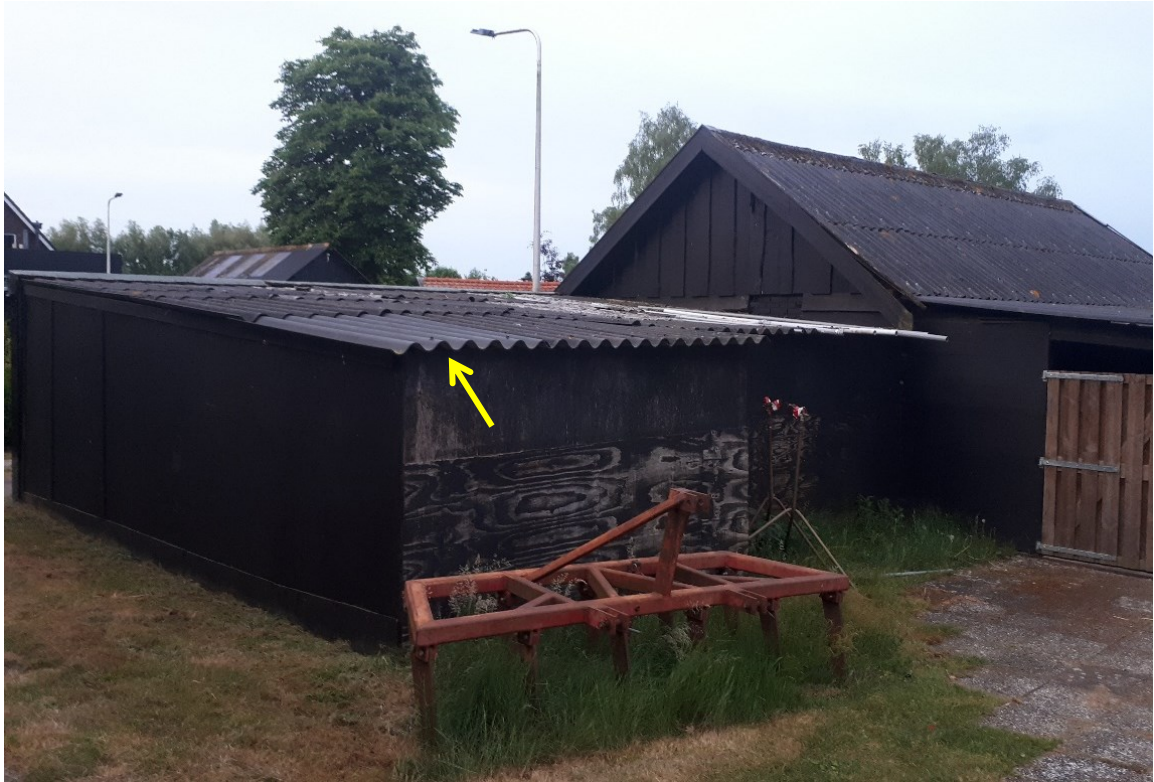
Figuur 10. Schuur waar zich een rust- of verblijfplaats van een steenmarter bevindt. De steenmarter ging het gebouw binnen via een opening onder de dakbedekking.
