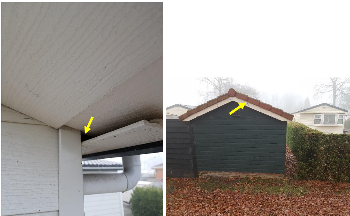
Figuur 6: Enkele voorbeelden van potentiële verblijfplaatsen van gebouwbewonende vleermuizen. Openingen onder de dakrand van vakantiehuisje O (links) en openingen langs de kantpannen van een tuinschuurtje (rechts).
