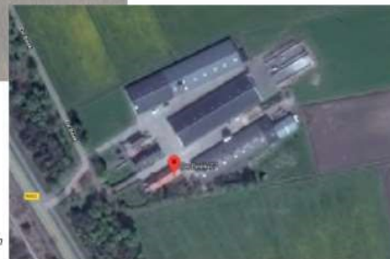
Oorspronkelijke situatie met schuren en kuiploten
