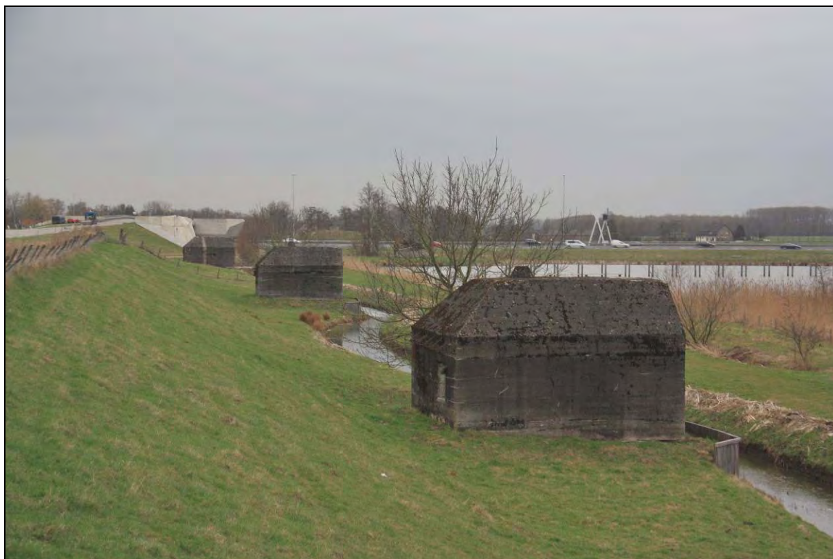
Groepsschuilplaatsen langs de Diefdijk ten zuiden van de A2.
