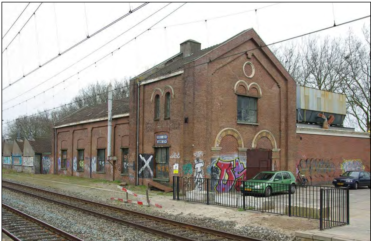
De voormalige locomotiefloods.
