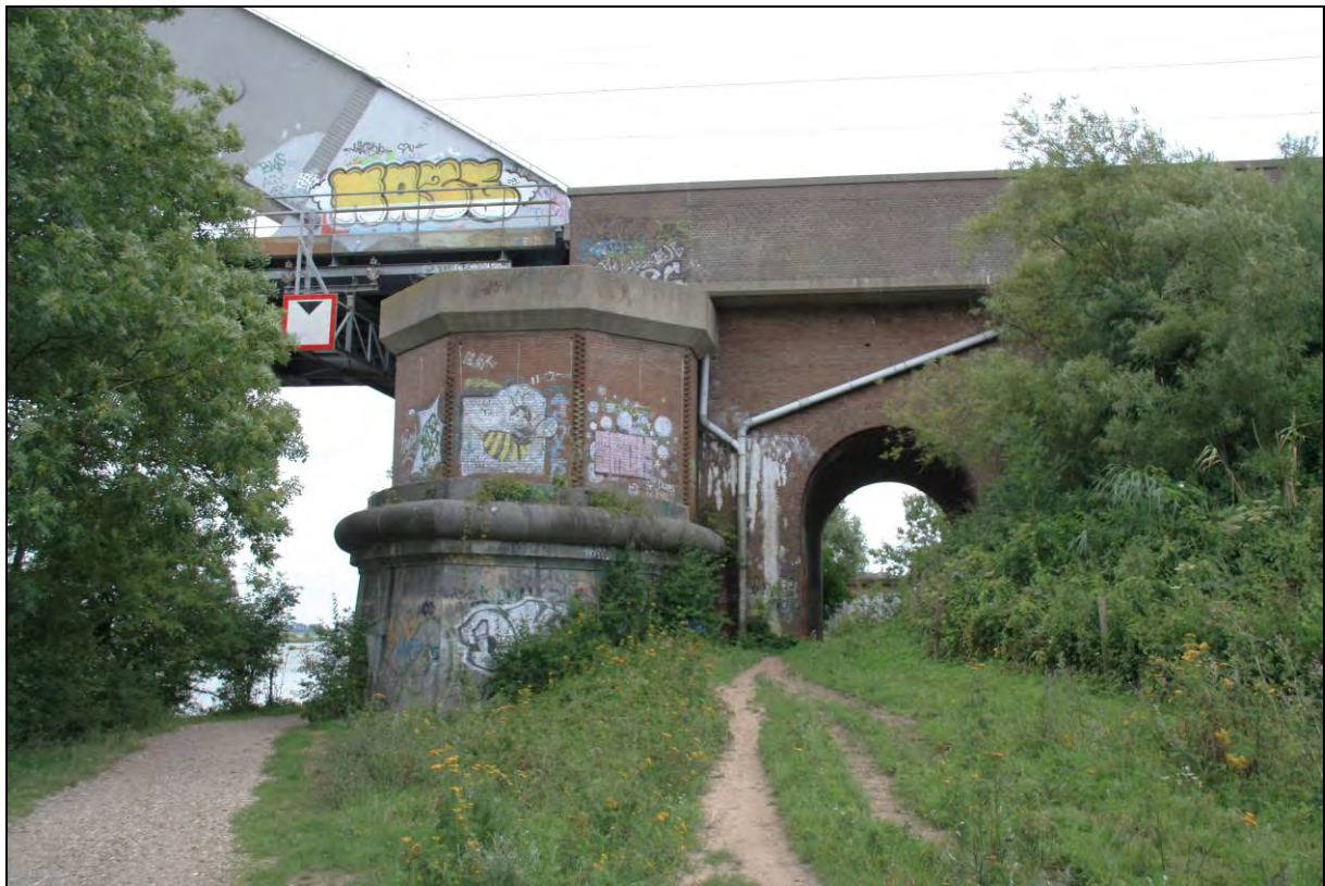
Spoordijk met de zuidelijke pijler, de tunnel en het begin van de grote overspanning van de spoorbrug over de Lek.
