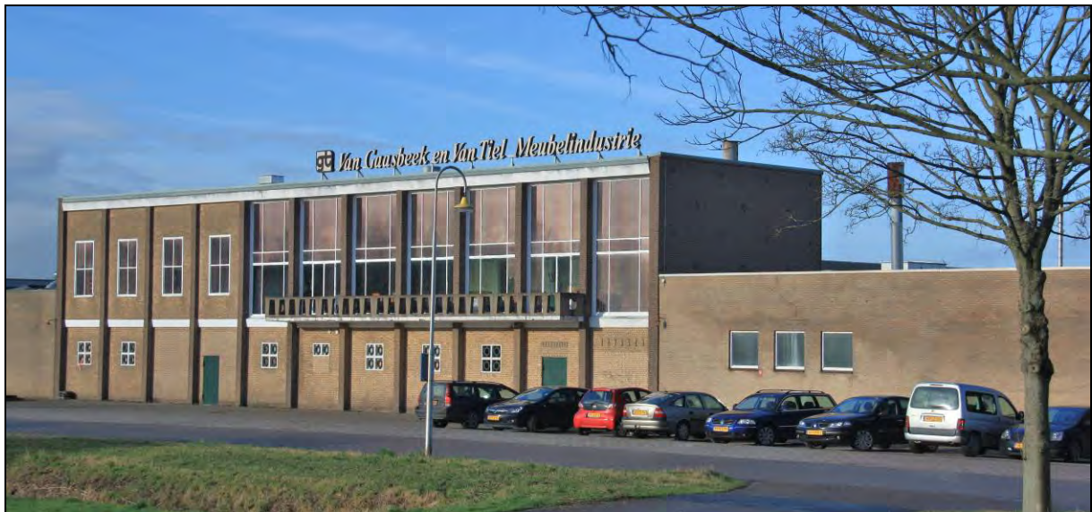
De meubelfabriek Van Gaasbeek en Van Tiel is een waardevol industrieel complex.
