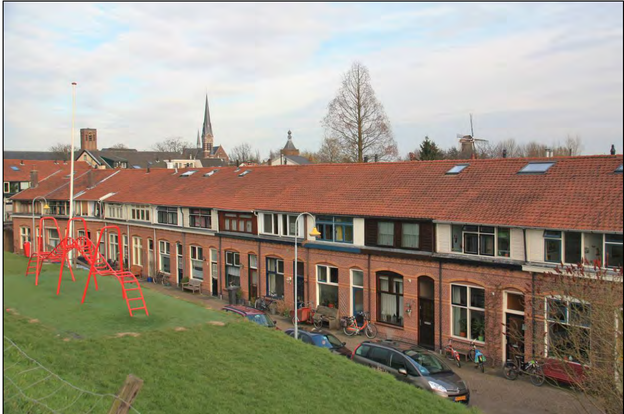
Arbeiderswoningen aan de Lekdijkstraat.
