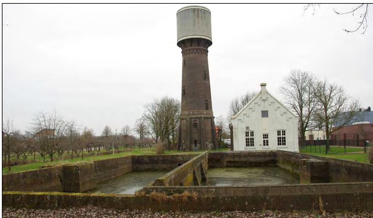
De watertoren, het pomphuis en de bezinkbakken.
