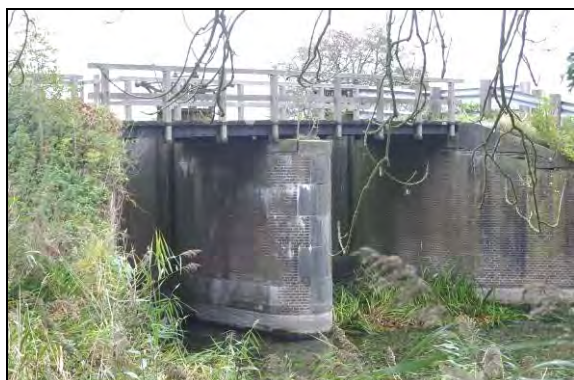
De inlaatsluis in de zomerkade (links) en de beersluis in de Goilberdingerdijk (rechts) van Fort Everdingen.
