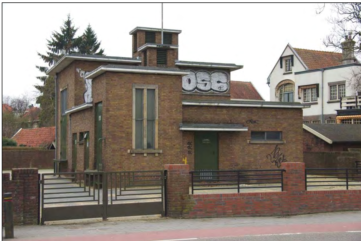
Het schakelstation van de PGEM aan de Lanxmeersestraat.
