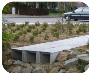
Zichtbare koppeling wadi structuren (water en dier)
