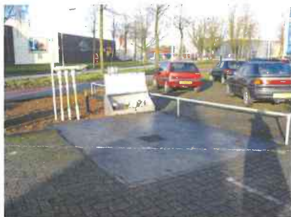
Aanzicht opstelplaats vulpunten
