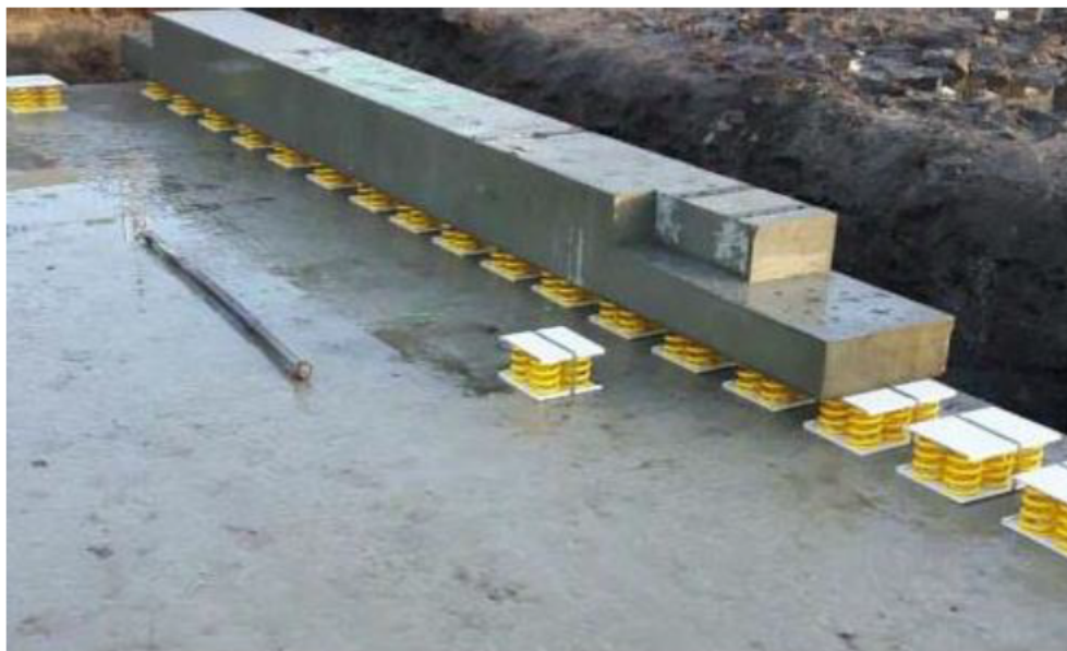
Figuur 32 Dubbele fundering met stalen veerdozen (project in Prinsenbeek)
