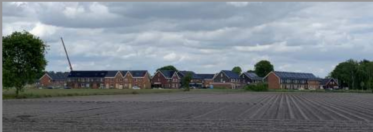
Zicht vanaf de Bouwhuisweg op deelgebied 1
