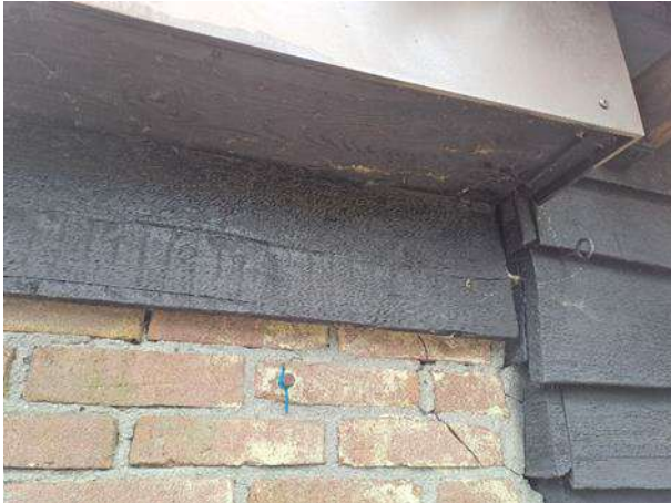
De houtbetimmering sluit strak aan op de buitengevels.
