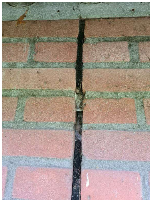
Figuur 4.2: gedeeltelijk ontbreken band
