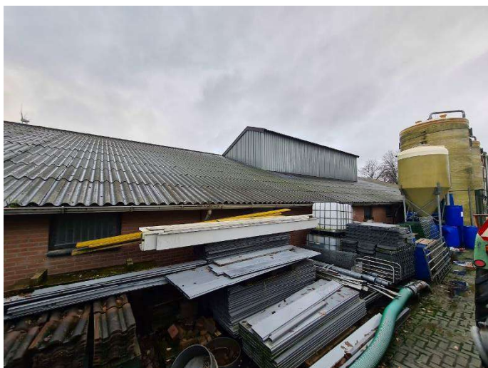
Figuur 2.3: zuidgevel + dakopbouw
