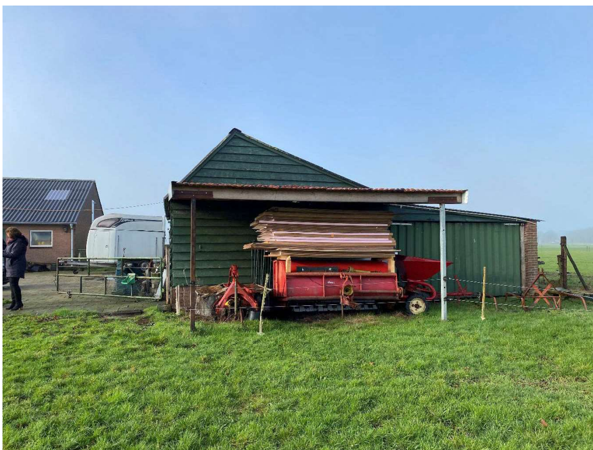
Huidige situatie locatie te bouwen kleine schuurwoning en bijgebouw.
