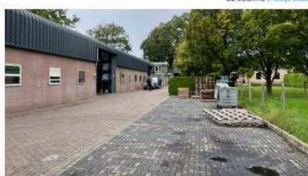
De bestaande bestrooiing met weg naar toegang, strook met parkeerplaatsen zijn ergerd van de buurt
