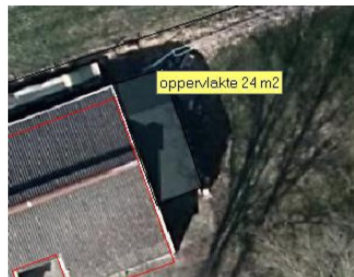
huidige situatie overkapping
