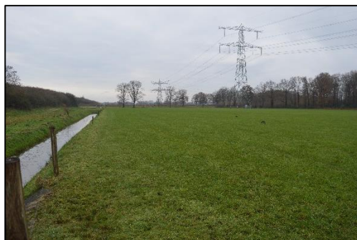
Figuur 3.12. Uittredepunt HDD5 en open ontgraving.
