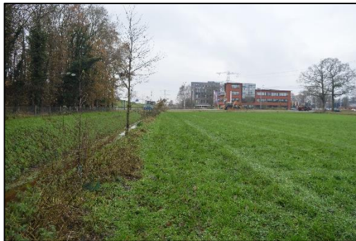
Figuur 3.14. Uittredepunt HDD6 en open ontgraving.
