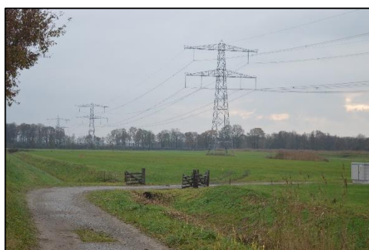
Figuur 3.8. Uittredepunt HDD3 en open ontgraving.
