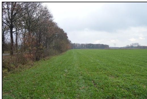
Figuur 3.6. Uittredepunt HDD2 en open ontgraving.
