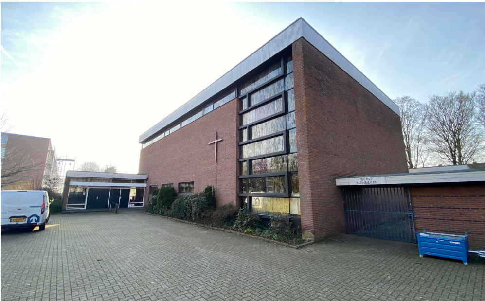
De kerkzaal, hoog boven de bijgebouwen uit, links de toegang, rechts de luifel naar de fietsenstalling.
