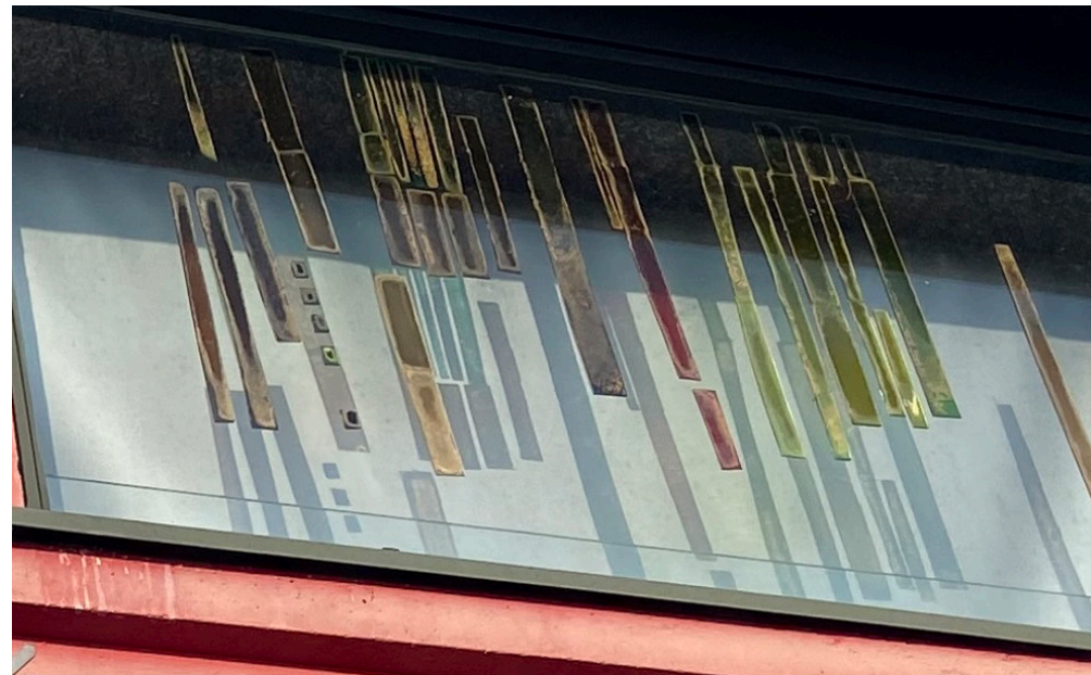
Afb. 10 Glasstrookjes op de ruit gelijmd.
