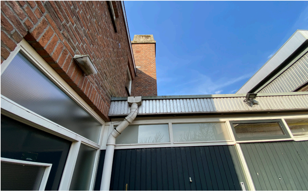
Detail van het tussenlid tussen de nevenruimten bij de kerk en de woning.
