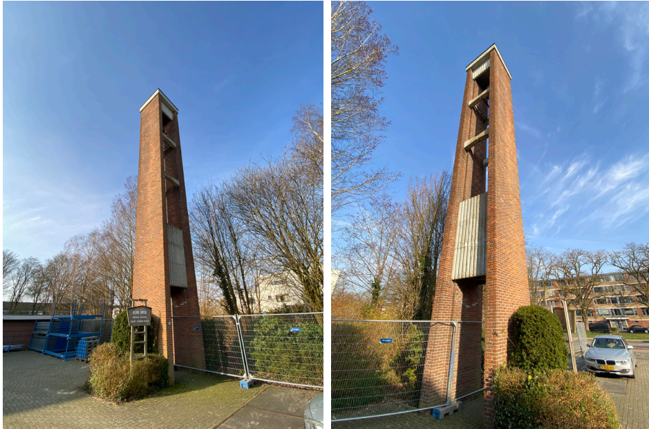
De toren als baken in de wijk, gesitueerd op de grens van het groene voorplein en de parkeerplaats.
