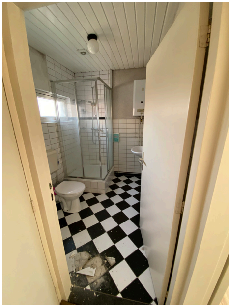
Woning, eerste verdieping, badkamer.
