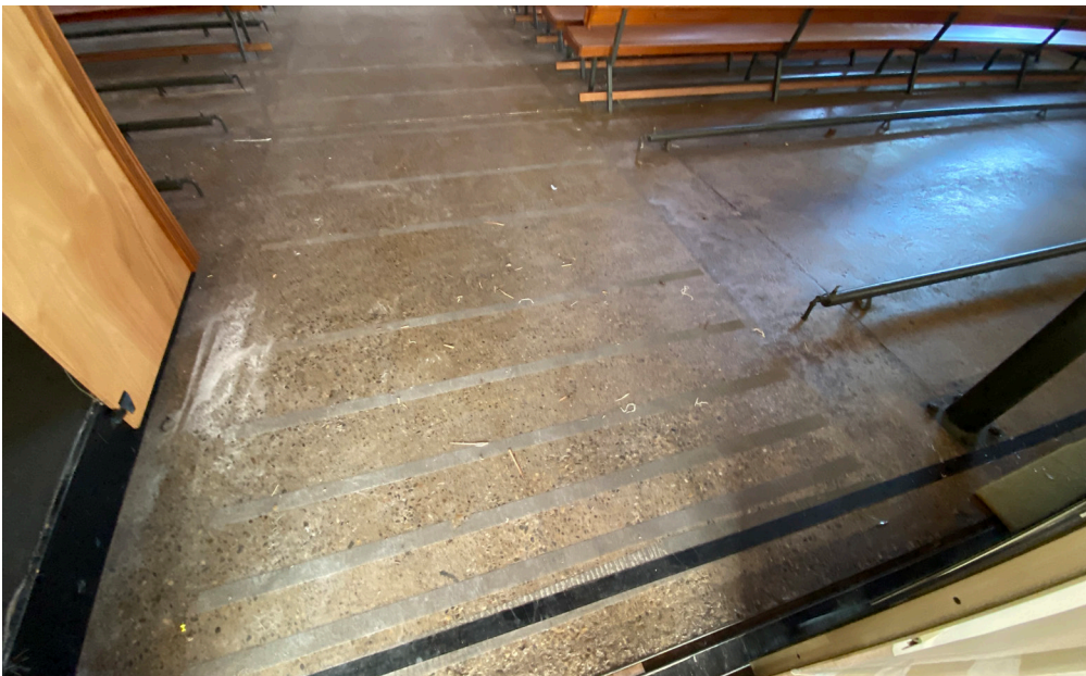
Kerkzaal, detail grintbetonnen vloer.
