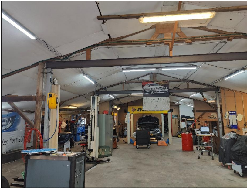
Steenmarters kunnen een verblijfplaats bezetten tussen golfplaten en dakisolatie.
