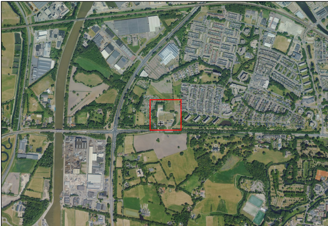
Figuur 1.4 ligging hoog- en middenspanningsstation Mosterdpot (rood omlijnd) (bron: Streetsmart)
