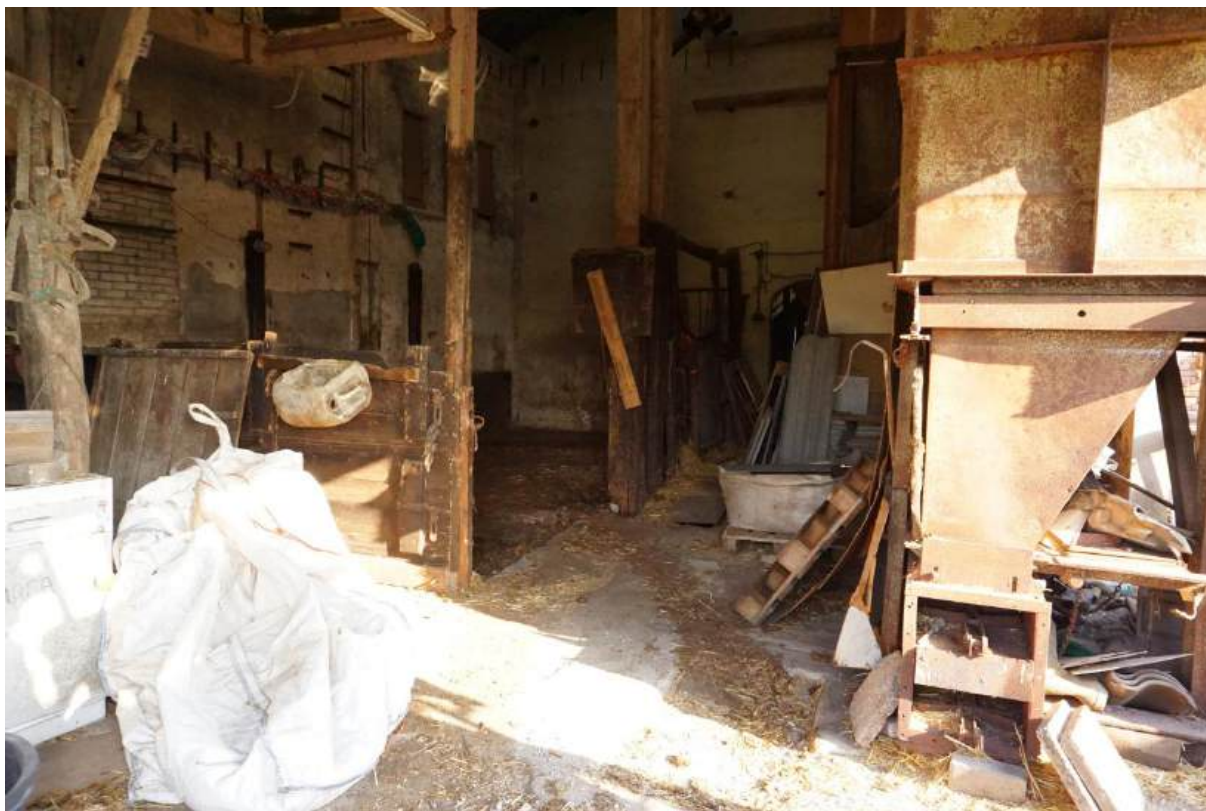
Figuur 1.5 In het gebouw zijn veelal oude constructies, hout, tassen en dergelijke aanwezig.
