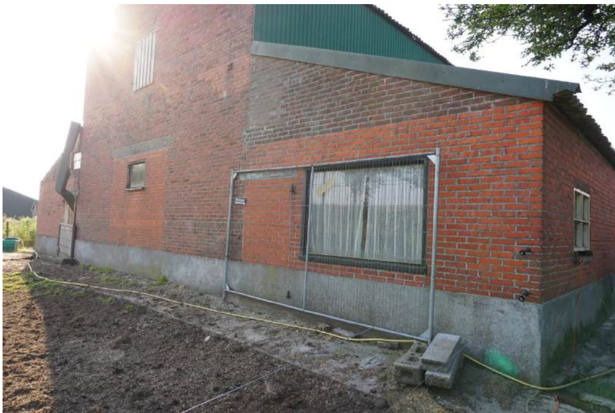
Figuur 1.4 Overzicht van de achterzijde van het gebouw.
