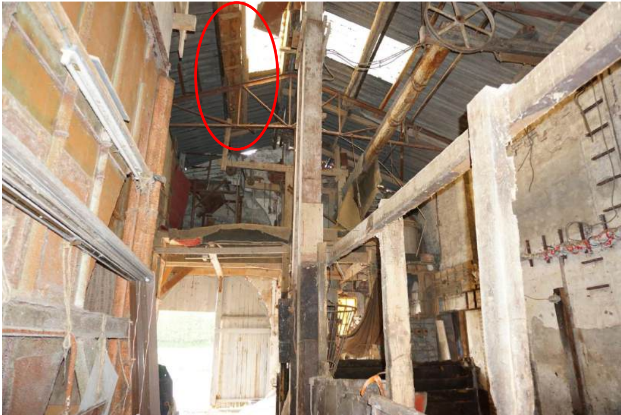
Figuur 4.4 Tussen het golfplaten dak en de gordingen kunnen verblijfplaatsen van vleermuizen aanwezig zijn.
