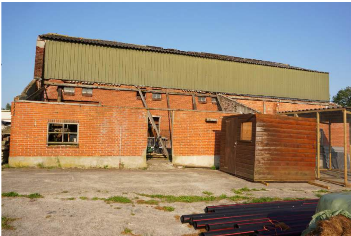
Figuur 1.3 Overzicht van de oostelijke gevel van het gebouw.
