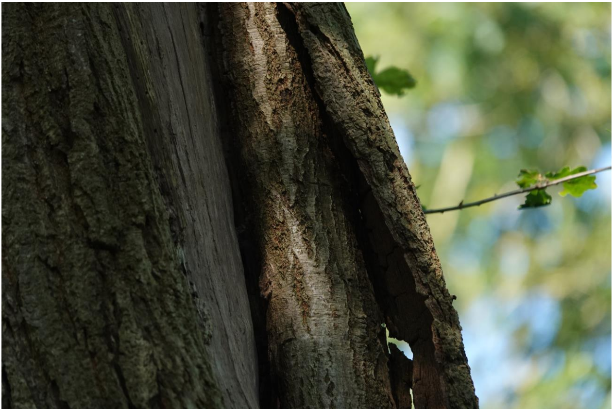
Figuur 4.4 Aan de oostelijke rand van het plangebied is een beschadigde eik aanwezig die potentieel geschikt is voor verblijfplaatsen van vleermuizen.
