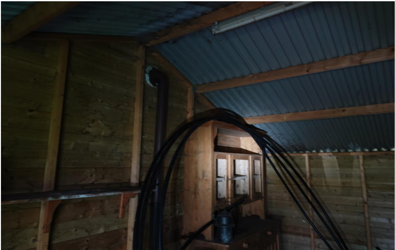
Figuur 4.3 Indruk van de binnenzijde van de schuur.
