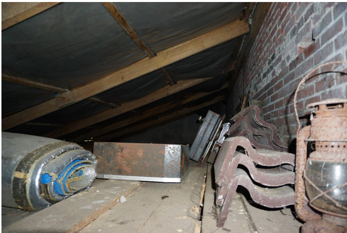
Figuur 4.5 De zolderruimte kan potentieel gebruikt worden als verblijfplaats van steenmarter.
