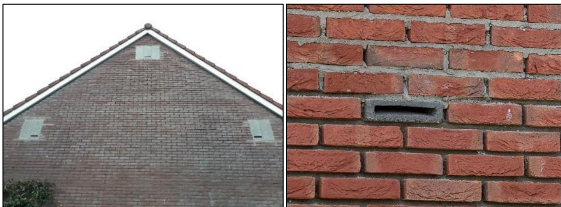
Figuur 6.10 Geschakelde inbouwstenen voor vleermuizen (links) en inbouwsteen gemetseld achter gevelstenen (Foto's: M. Heinen, Ecogroen en VivaraPro).
