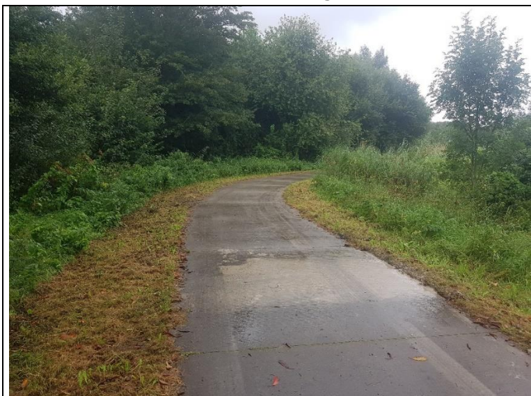
Foto 5: fietspad verhard met beton
