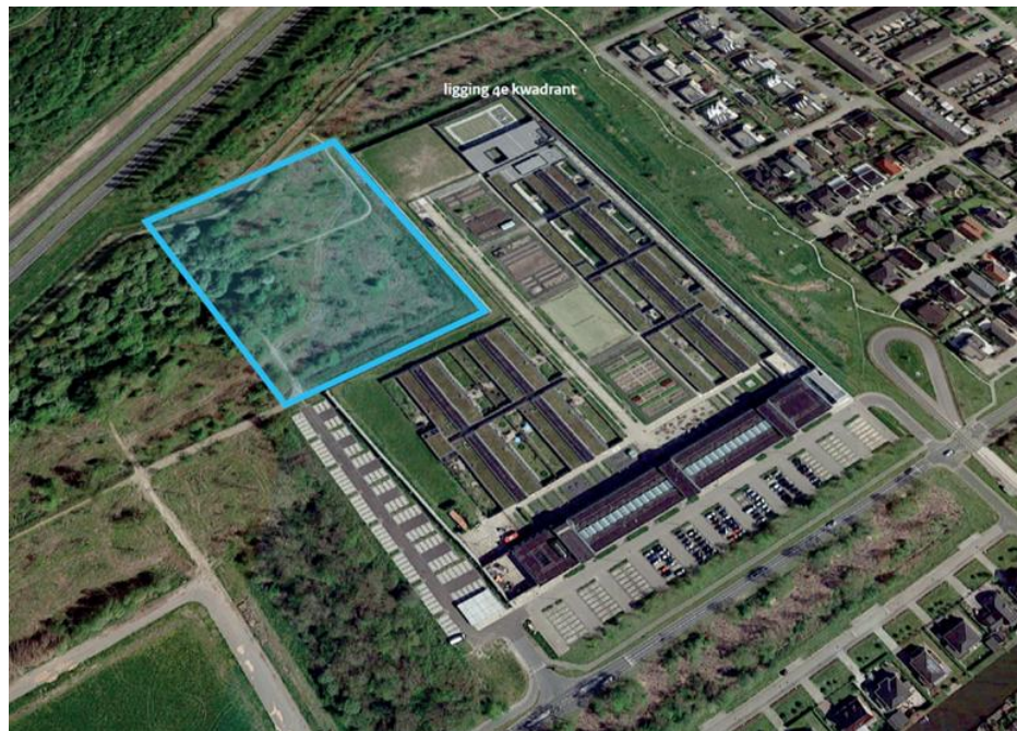
Afbeelding 1. Luchtfoto bestaande situatie 2020.
