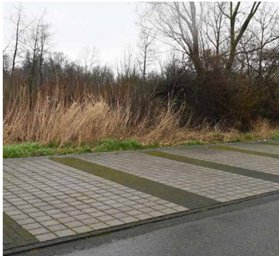
20 x20 cm tegels omlijst met zwarte betonstraatstenen rijbaan asfalt
