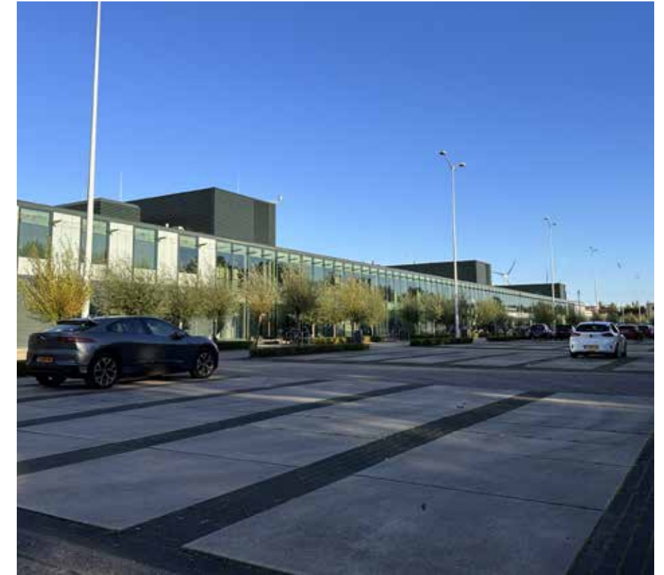
stelconplaten 2 x 2 meter, randen zwarte betonstraatstenen
