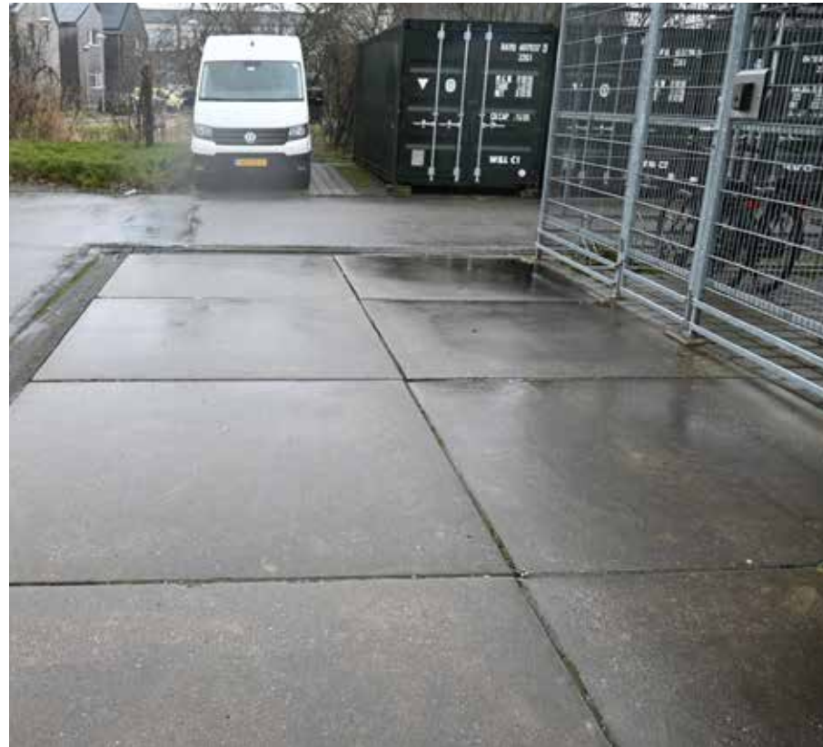
stelconplaten 2 x 2 meter
