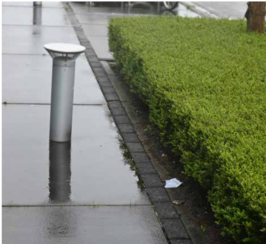
stelconplaten 2 x 2 meter, randen zwarte betonstraatstenen
