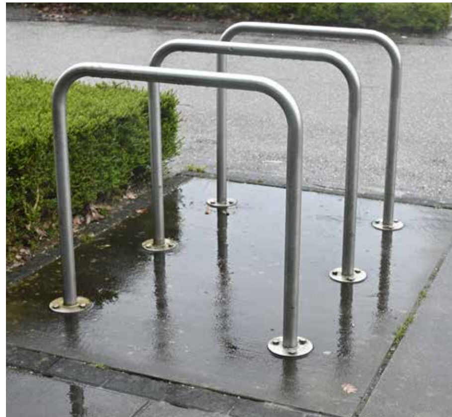
Fietssteunen op betonplaat gemonteerd
