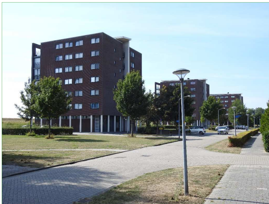
Appartementengebouwen ten zuiden van de wijk De Velden in Almere Haven. In de spouwmuur van deze gebouwen werden relatief veel baltsverblijven van Ruige dwergvleermuis aangetroffen.
