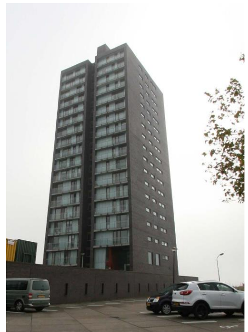
Figuur 1 Woongebouw op oostelijke havenhoofd
